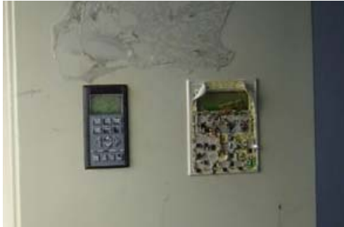
Schaden am Steuerschrank
