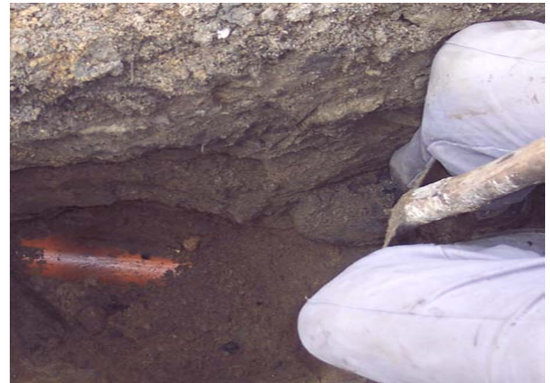
Handelsübliches KG-Rohr als Gasleitung
