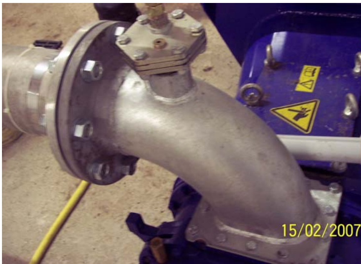
Übergang Edelstahl / Stahl verz. / Stahl lackiert
