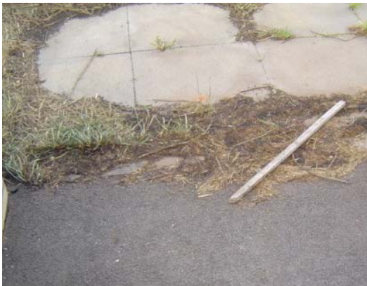
Brandspuren vor dem Gebäude
