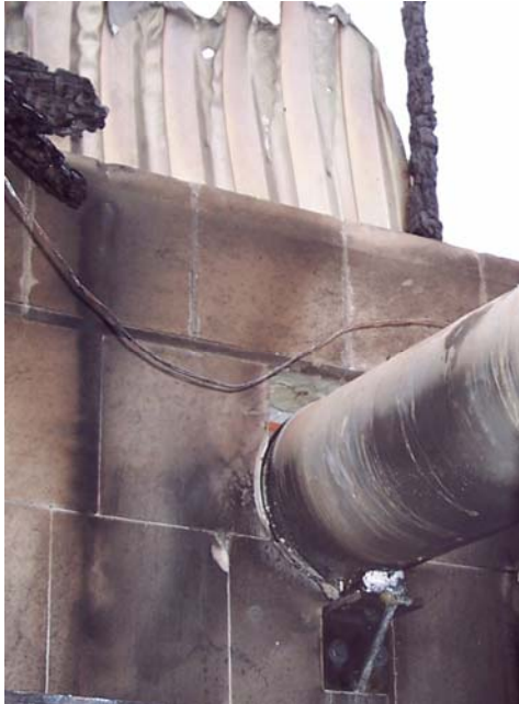
Brandschaden an einem BHKW-Gebäude
