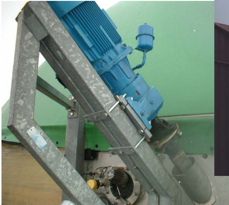
Gegen Schwingungen gesichertes Rührwerk
